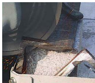
VIGAS DE HIERRO
